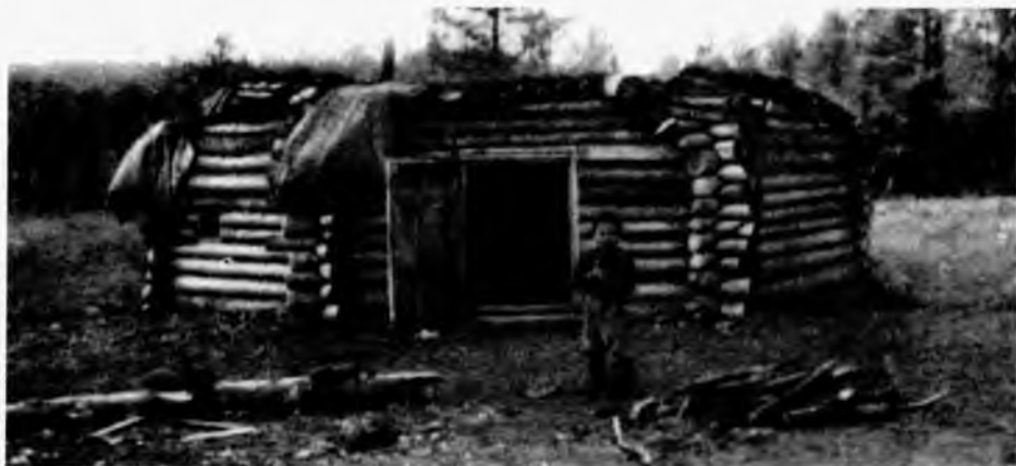
Рис. 34. Плоскокровельный многоугольный сруб. Тувинцы. По А.А. Попову (1961. Табл. 19, 4) Fig. 34. Flat roof polygonal log frame cabin. The Tuvincians
