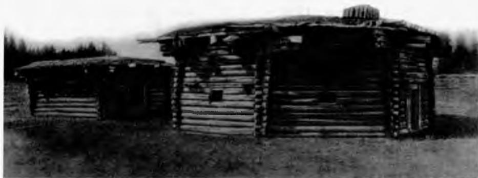
Рис. 33. Плоскокровельный многоугольный сруб. Якуты. По А.А. Попову (1961. Табл. 22, 2) Fig. 33. Flat roof polygonal log frame cabin. The Yakuts
