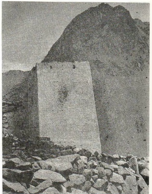
Рис. 29. Башня Ак-Кала в с. Безенги
