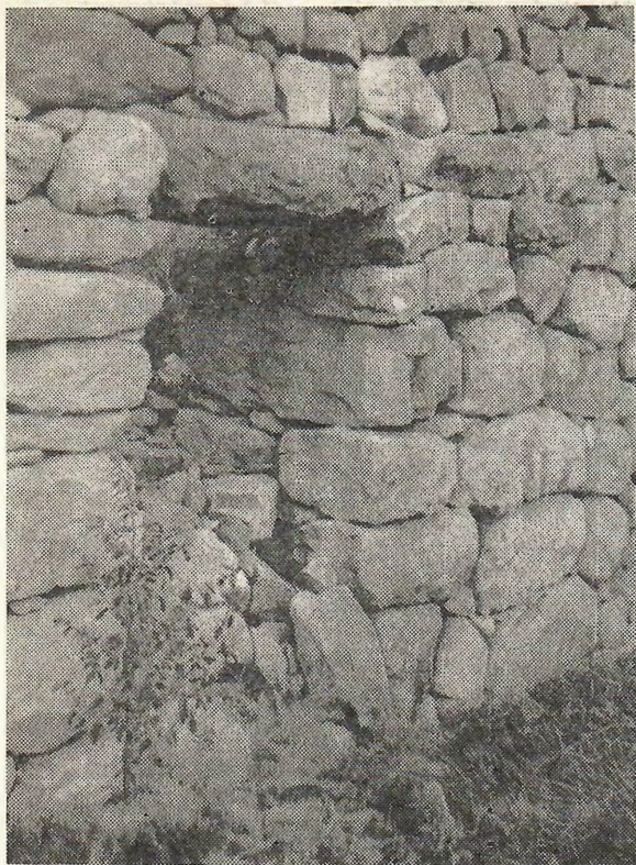
Рис. 10. Каменная перемычка оконного проема, с. Зылги
