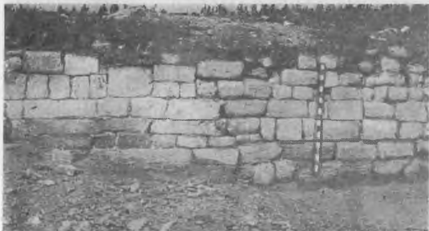
Рис. 6. Южная стена башни и часть восточной стены городища после расчистки
