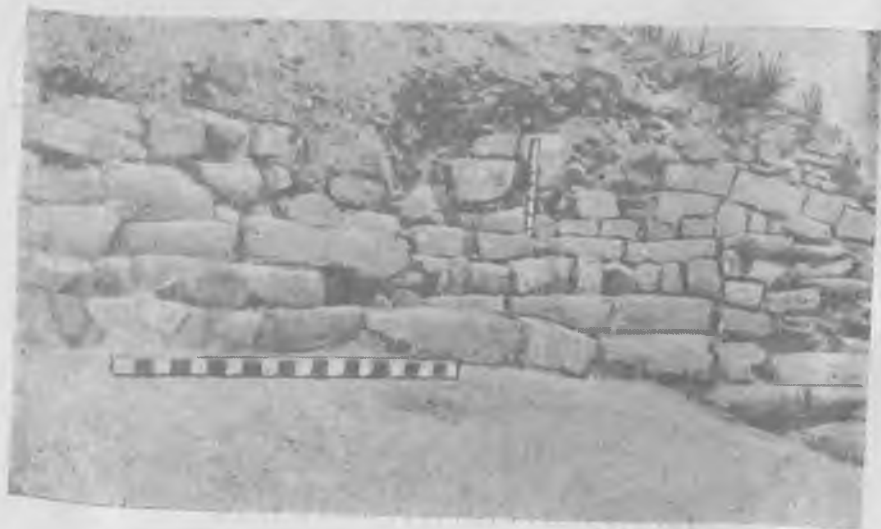
Рис. 8. Детали кладки внутренней части стены цитадели
