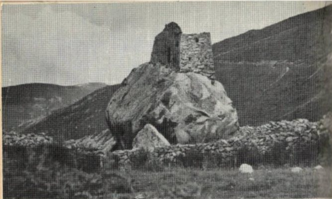
Рис. 57. Верхне-Балкарская башня «Амирхан-Кала» (№ 338).
