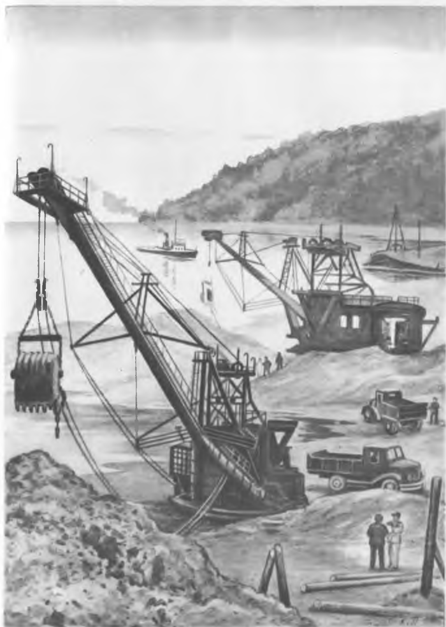
На строительстве электростанции.
