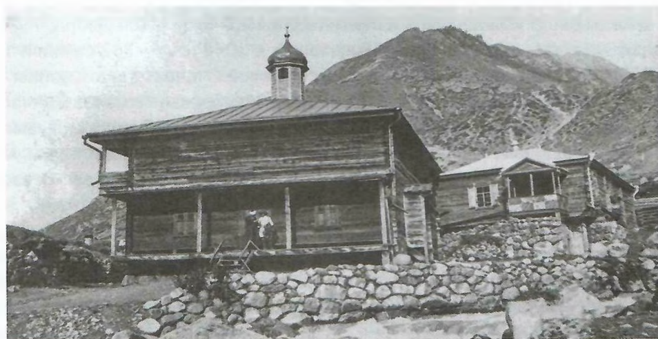
Мечеть и жилые дома в Верхнем Баксане на высоком каменном цоколе со срубными деревянными стенами
