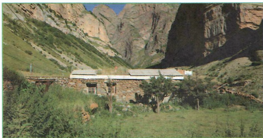
Остатки Башни Личиу-Кала в нижнем левом углу и под деревьями у стены кошары, построенный из камня разрушенной башни
