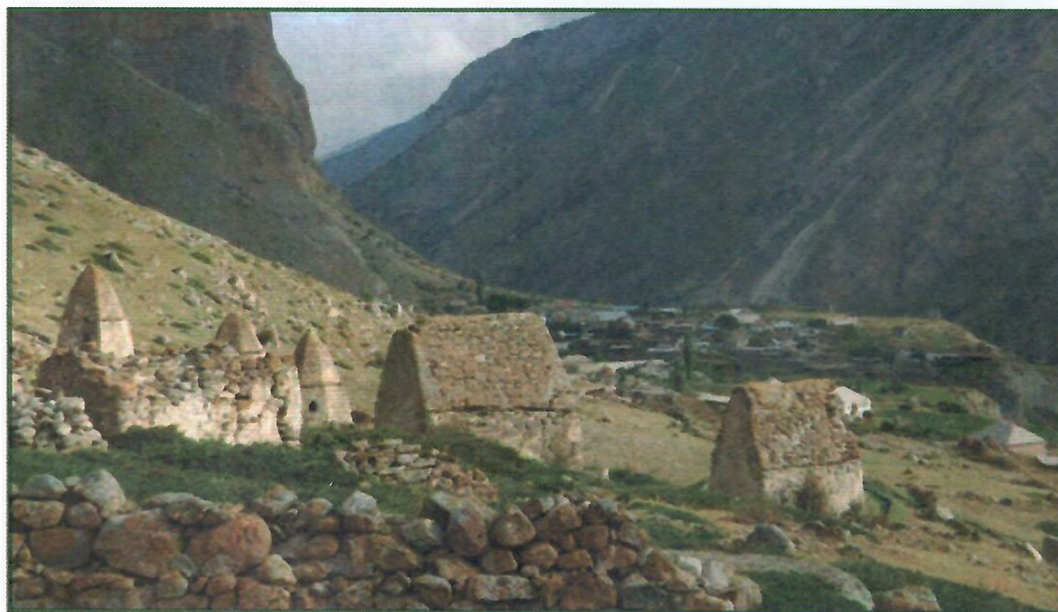
Вид на село Верхний Чегем от некрополя Фардык. На переднем плане сохранившиеся и полуразрушенные прямоугольные мавзолеи
