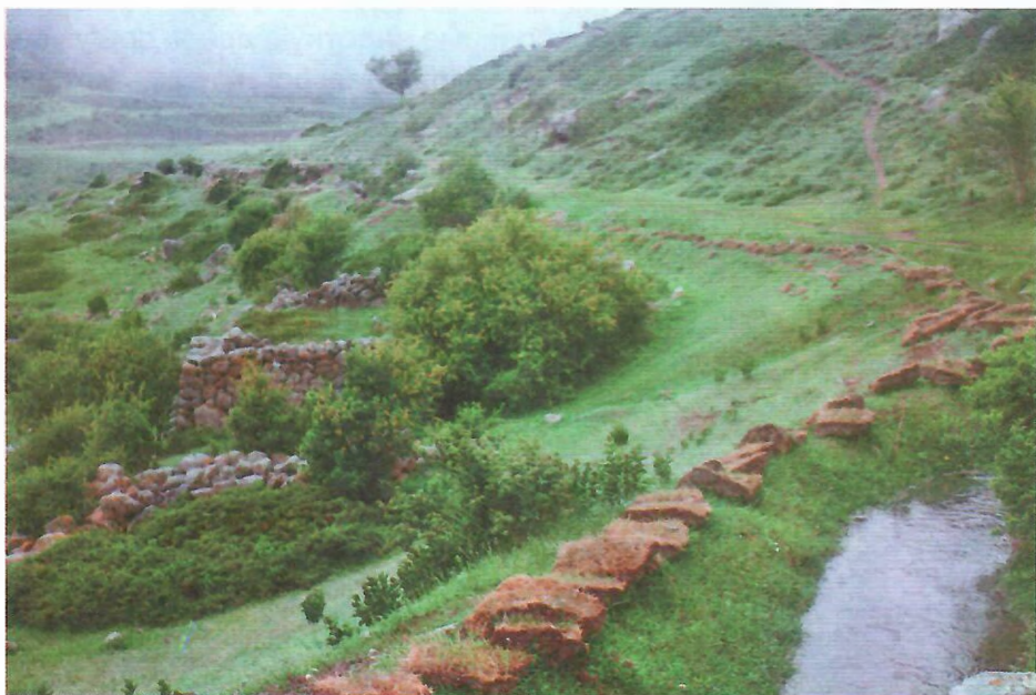
Водопровод – оросительный канал по склону горы
