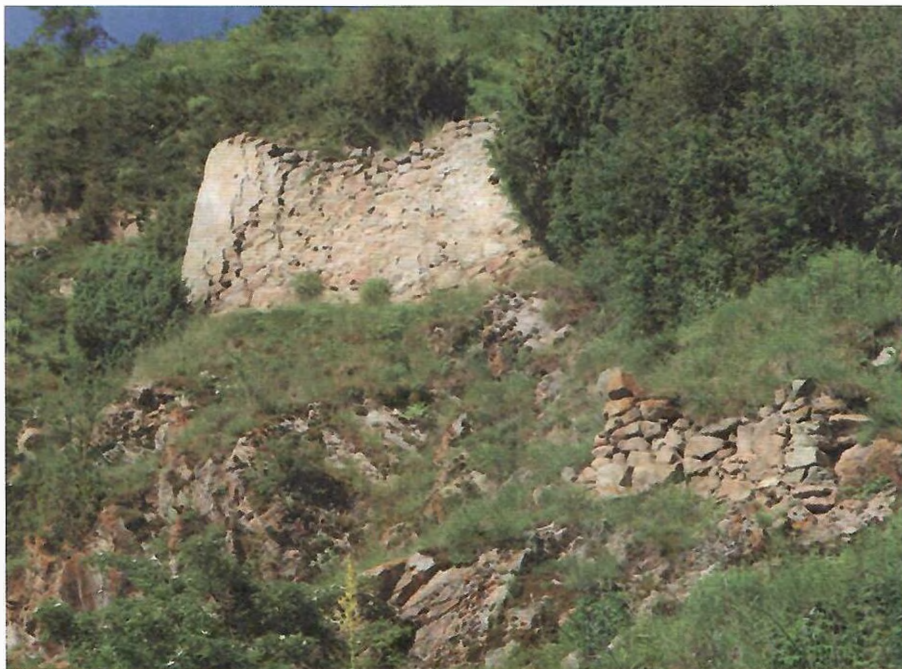
Фрагменты стен Кюнлюм-Кала
