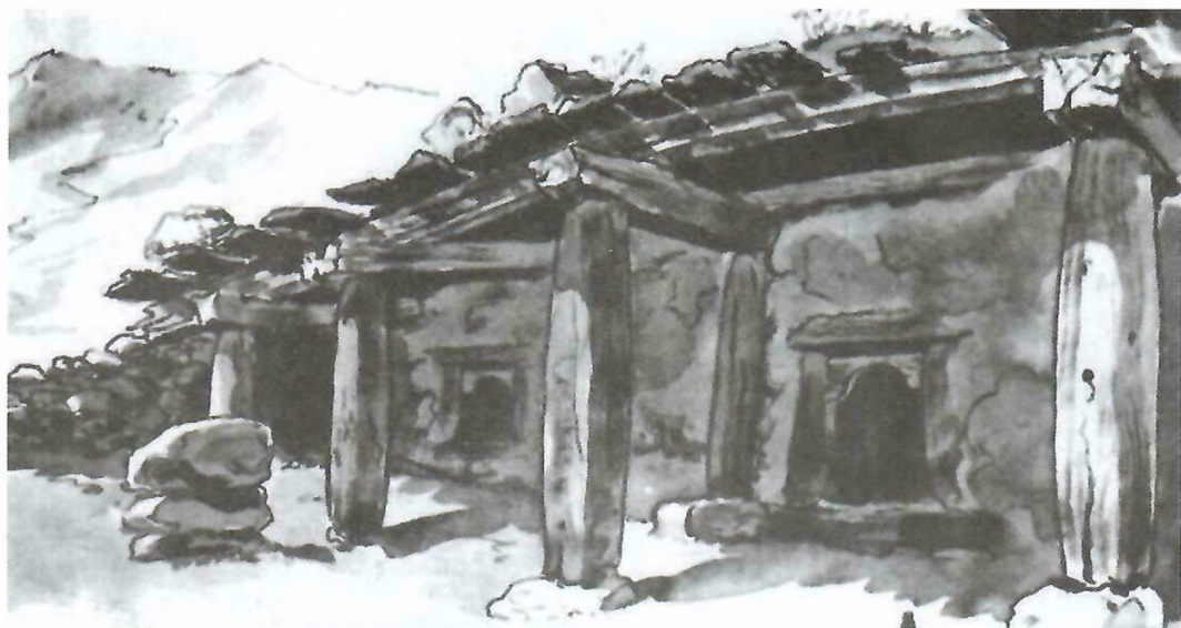
Фрагмент навеса дома князя Малкарукова в Эльтубю. Фигурные дверные проемы накрыты каменной плитой (рисунки Э.Б. Бернштейна)
