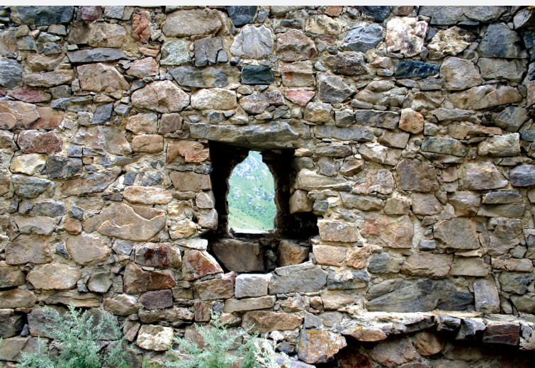
Верхняя Балкария, фрагмент башни
