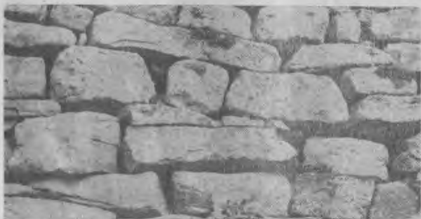
Рис. 3. Деталь кладки крепостной стены Амгатинского городища.
