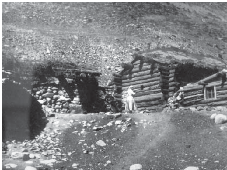
Баксанское ущелье, вторая половина XIX века. Старый деревянный дом. Кровля засыпана землёй. Такое покрытие оберегало от камнепада. Дом из сосновых брёвен был прочный, тёплый и долговечный. Вторая половина XIX века.
