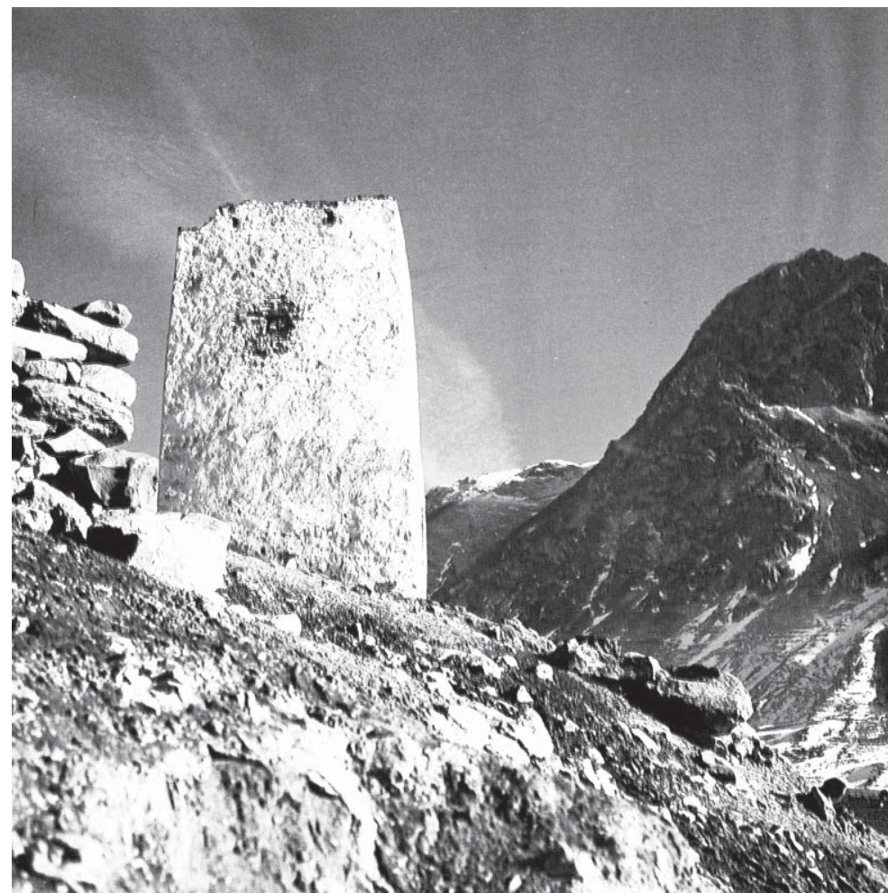
Башня Ак-Кала. Находится в верхней части села Безенги. Она почти квадратная. Имеет четыре этажа. Высота каждого 2-2,5 метров. Башня построена на прочном известковом растворе.
